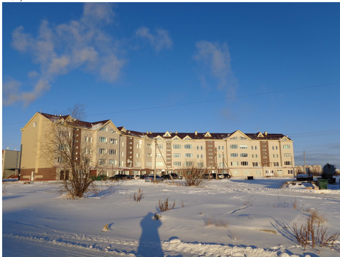
На снимке: дом (на весной мерзлоте), где цена фундамента-2% от сметы.
